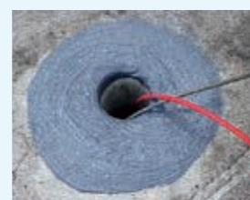
縦型ドレンの補修に
