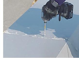
**用途** 薄鋼板同士の締結用 ゆるみ防止ビス けらば板金・水切り板金・棟板金などの役物止め
